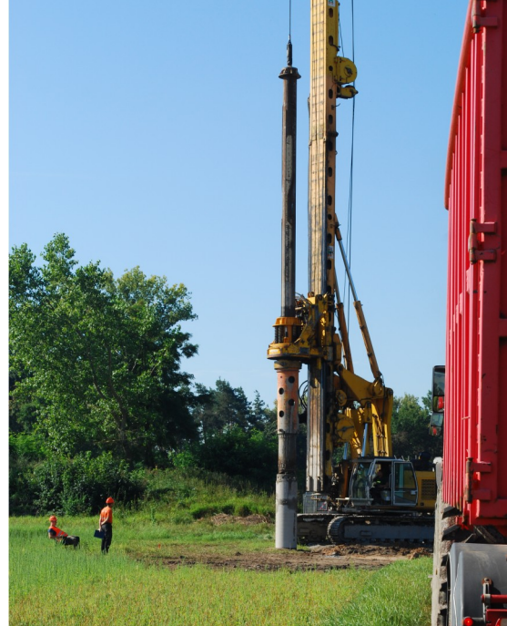
▲ Stavba lávky přes Labe
