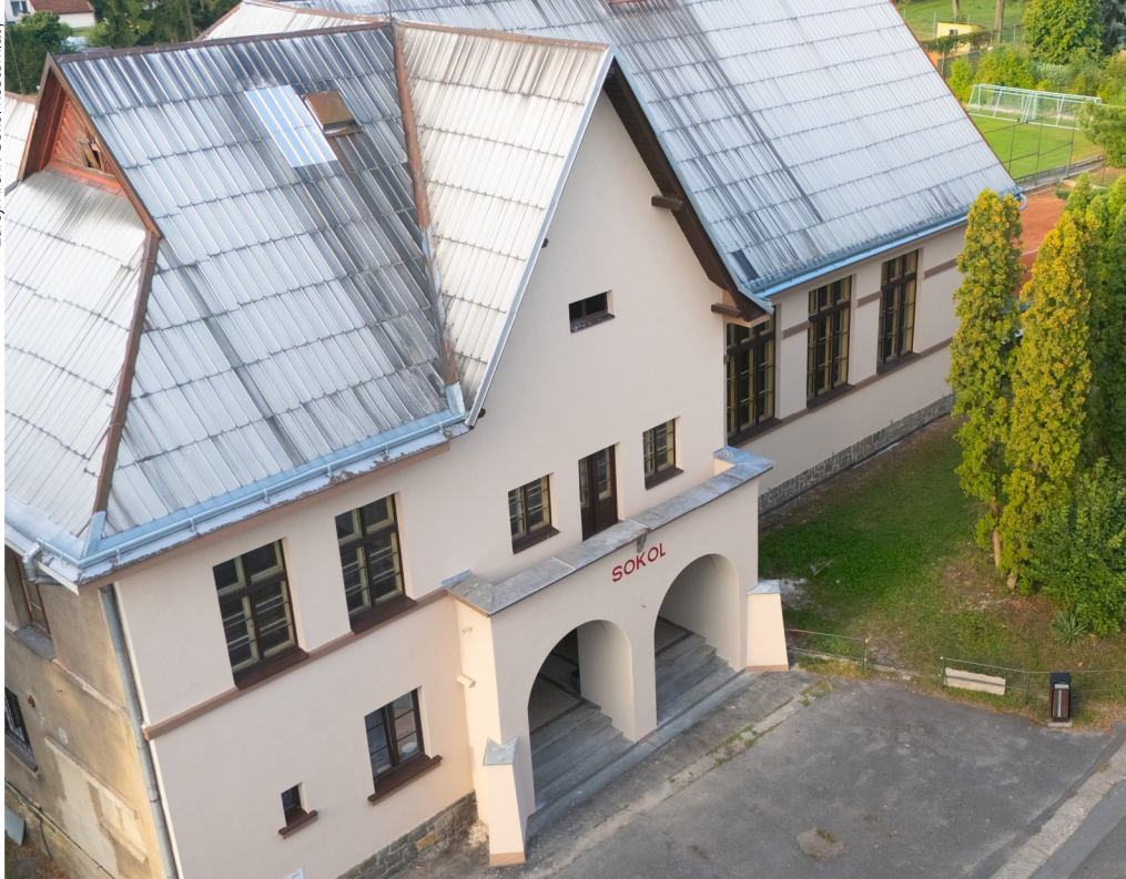
▲ Pohled na zrekonstruovanou fasádu Sokolovny
