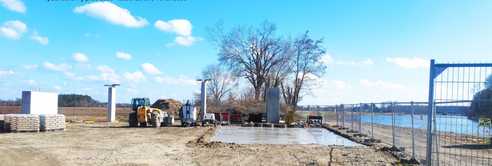
▼ Výstavba lávky přes Labe - záběr ze dne 13. 3. 2026
