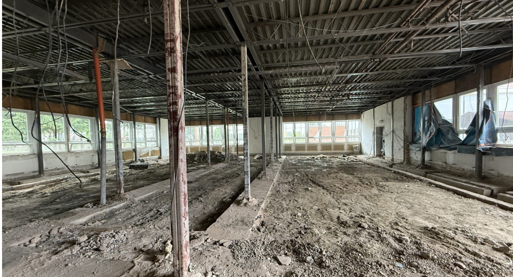
↑ Rekonstrukce školní kuchyně
