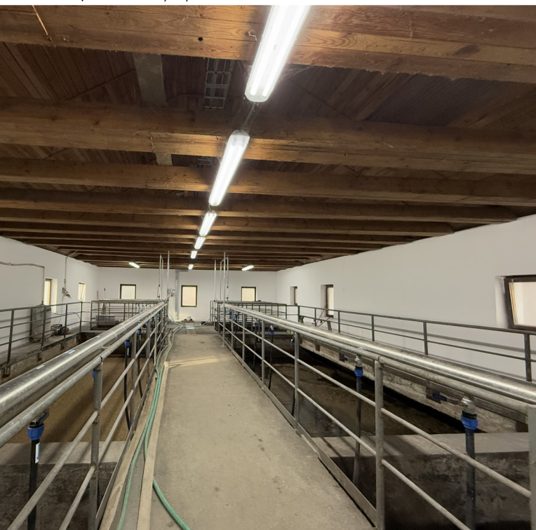
↓ Interiér čistírny odpadních vod
