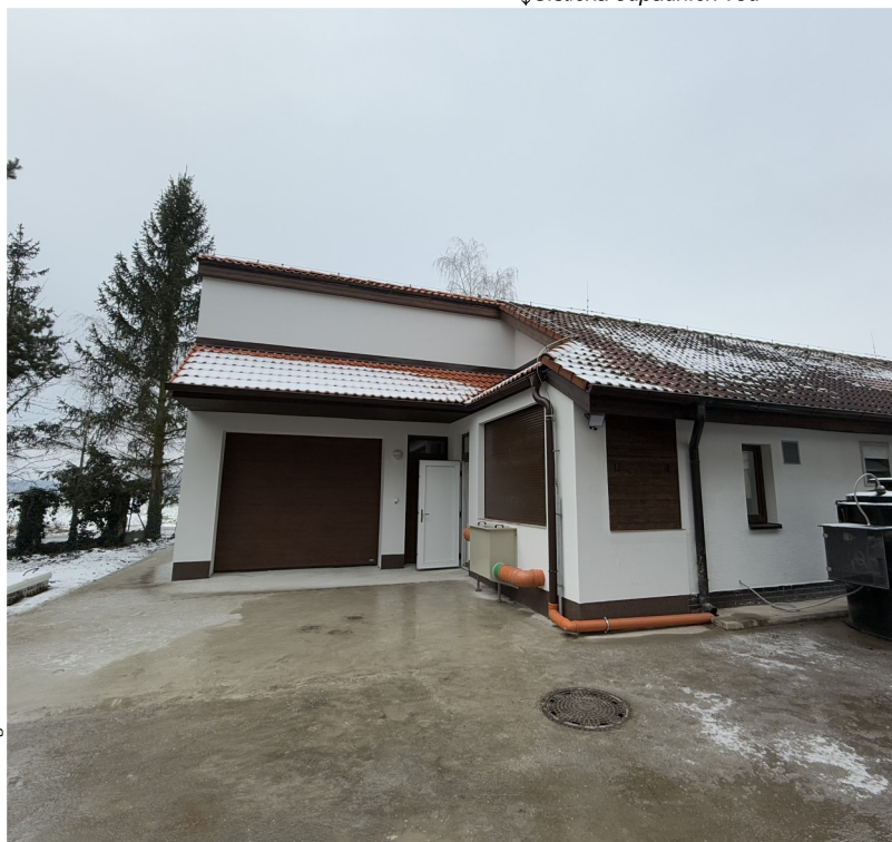
↓ Čistírna odpadních vod
