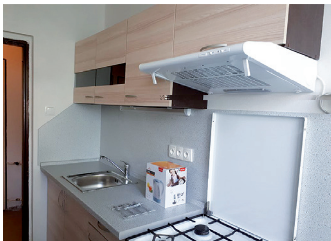
Oprava bytu ve škole
